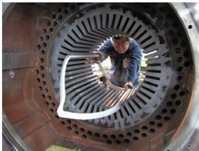
Slika 1. Prefabrikovani namotaj visokonaponske asinhronne mašine prilikom montiranja u statorski paket
