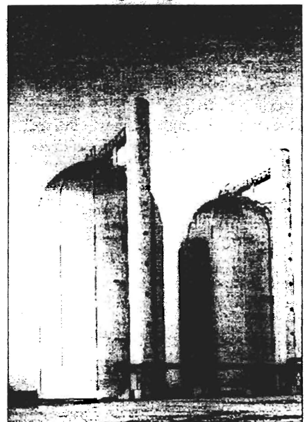
Slika 7 Dva akumulatora toplote instalirana u blizini Kopenhagena
